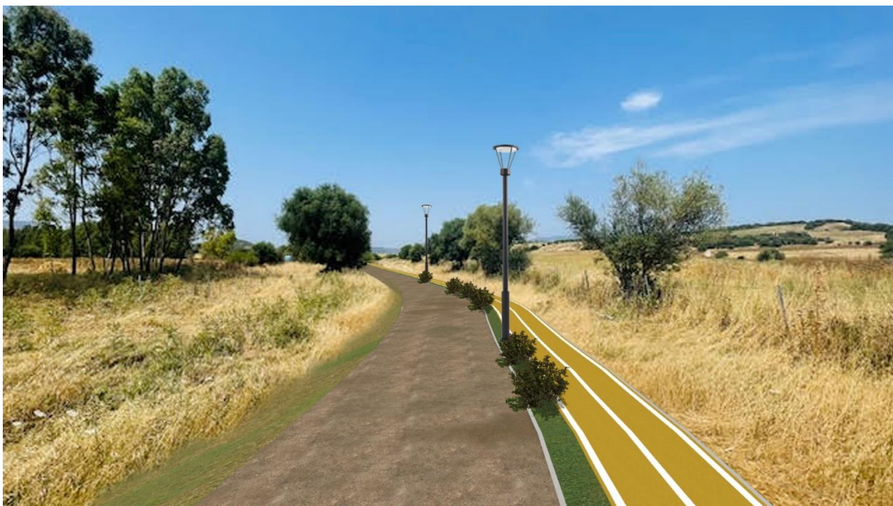
Stato di progetto – Strada di prosecuzione della via Stazione con pista ciclabile annessa (doppio senso di percorrenza). Impianto di illuminazione pubblica predisposizione per eventuale intervento di realizzazione della nuova strada, isola divisionale di separazione della pista dalla strada. Interventi di sagomatura e riprofilatura strada esistente e cunette laterali in terra.
