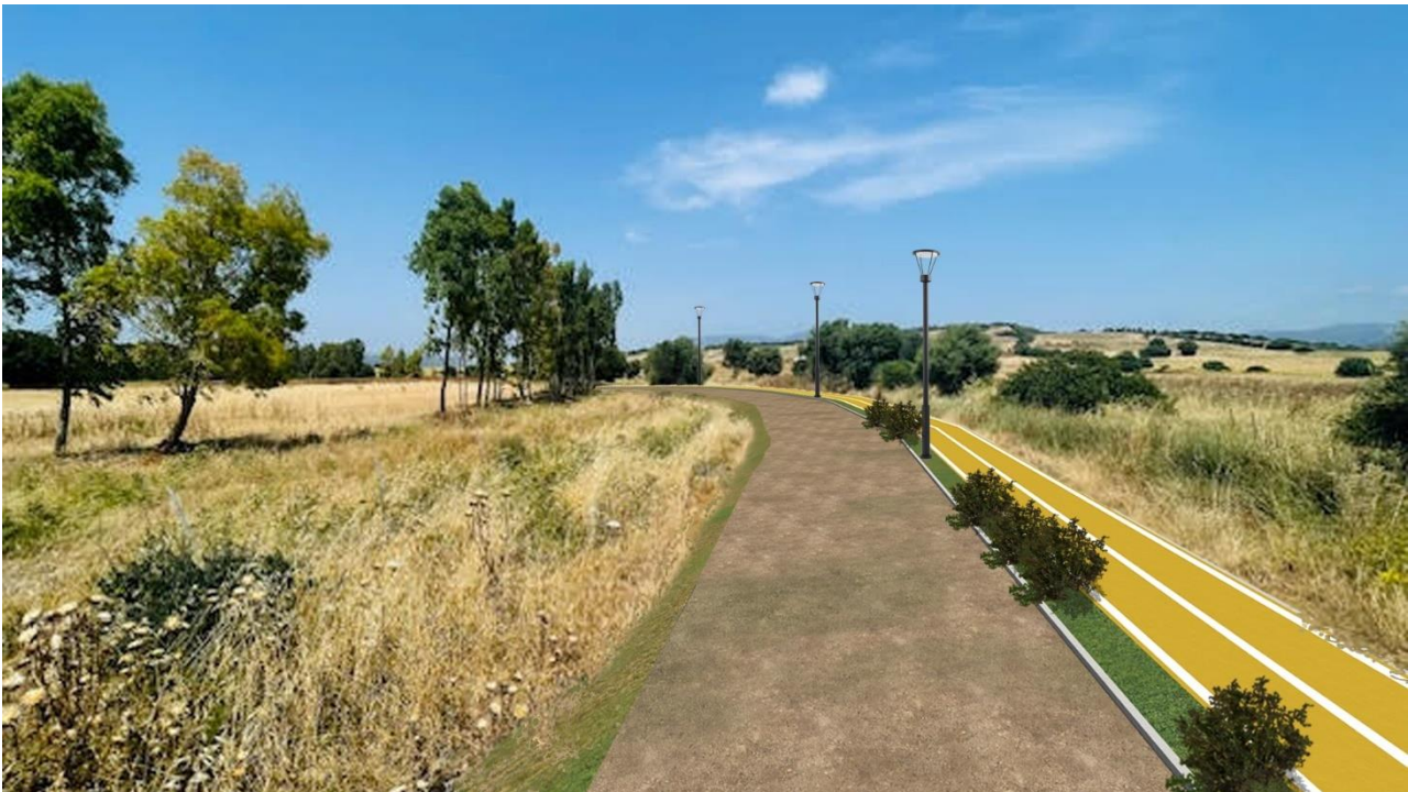
Stato di progetto – Strada di prosecuzione della via Stazione con pista ciclabile annessa (doppio senso di percorrenza). Impianto di illuminazione pubblica predisposizione per eventuale intervento di realizzazione della nuova strada, isola divisionale di separazione della pista dalla strada. Interventi di sagomatura e riprofilatura strada esistente e cunette laterali in terra.
